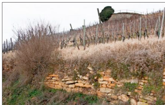
Eine von zwei Trockenmauern, die am Innerberg saniert werden soll.
